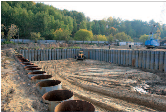
Фото 2. Укрепление берега, г. Городец Нижегородской области. Photo 2. Beach increasing, Gorodets town, Nizhny Novgorod region.
