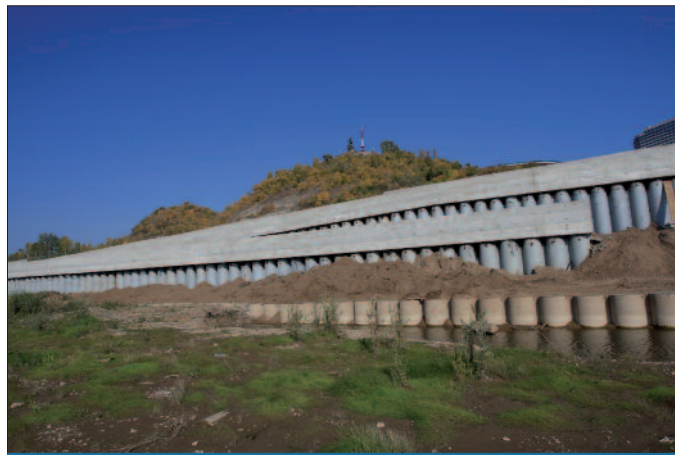
Фото 3. Укрепление берега р. Белая, г.Уфа. Photo 3. Beach increasing for Belaya river, Ufa region.
